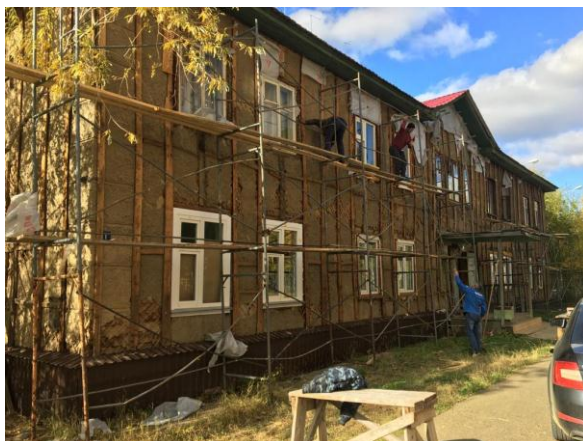
В ходе работ
